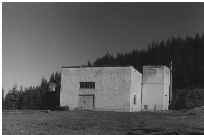
Fig. 5 Clădiri dezafectate de pe fosta platformă a exploatării Dadu.
